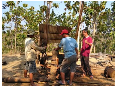
Gambar 5. Tali sling sudah terpasang
